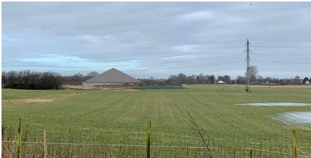
Indsigt fra Sverkilstrupvejen 52, set fra sydøst, med overdækning af stor gyllebeholder
